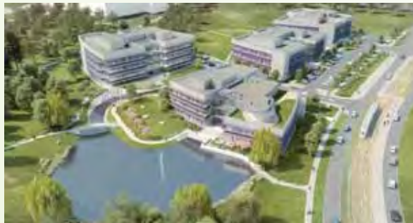
Brno prezentovalo mimo jiné projekt Centrální zóny v areálu Českého technologického parku, který zahrnuje výstavbu komplexu administrativních budov s centrálním vodním prvkem.
