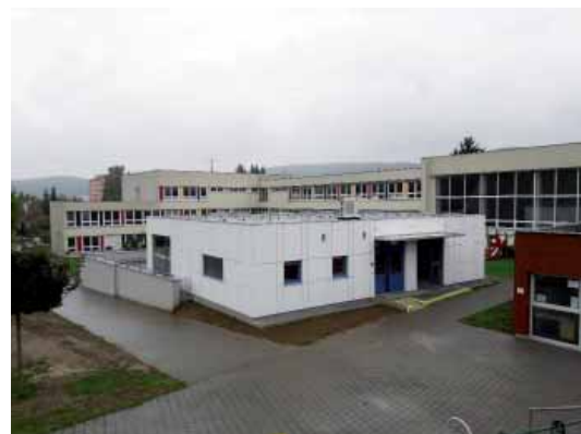
Nová budova MŠ Pastviny v Brně-Komíně postavená modulovou technologií
