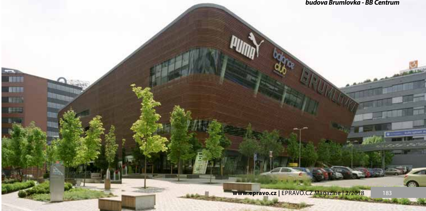
budova Brumlovka - BB Centrum
