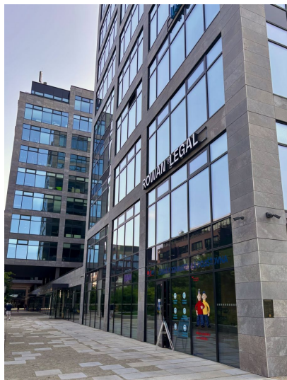
Vlněna Office Park, budova A
